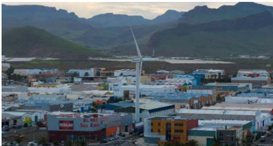
Comunidad energética del Polígono Industrial Arinaga, ubicado en el municipio de Agüimes, en la Isla de Gran Canaria.
